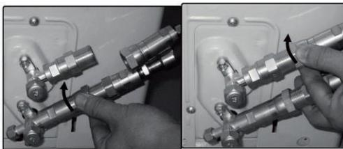
3. Drehen Sie am Gasventil die Mutter mit einem festen Schlüssel in Position 1 auf Position 2. Wiederholen Sie dies Schritt für das Flüssigkeitsventil. Bitte verwenden Sie das in der Tabelle angegebene Drehmoment.
