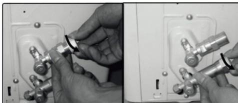
5.3 Après avoir aligné le centre, faites tourner l'écrou évasé du tuyau de raccordement pour serrer l'écrou aussi fermement que possible à la main.
