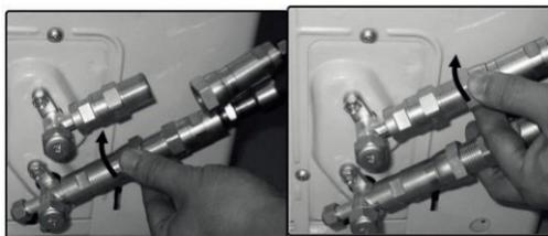
5.4 Au niveau du robinet de gaz, tournez l'écrou en position 1 avec une clé fixe en position 2. Répétez cette étape pour la vanne de liquide. Veuillez utiliser les valeurs de couple dans le tableau des exigences de couple. (Reportez-vous au tableau des couples de serrage requis dans la section **PRÉCAUTIONS D'INSTALLATION**)
